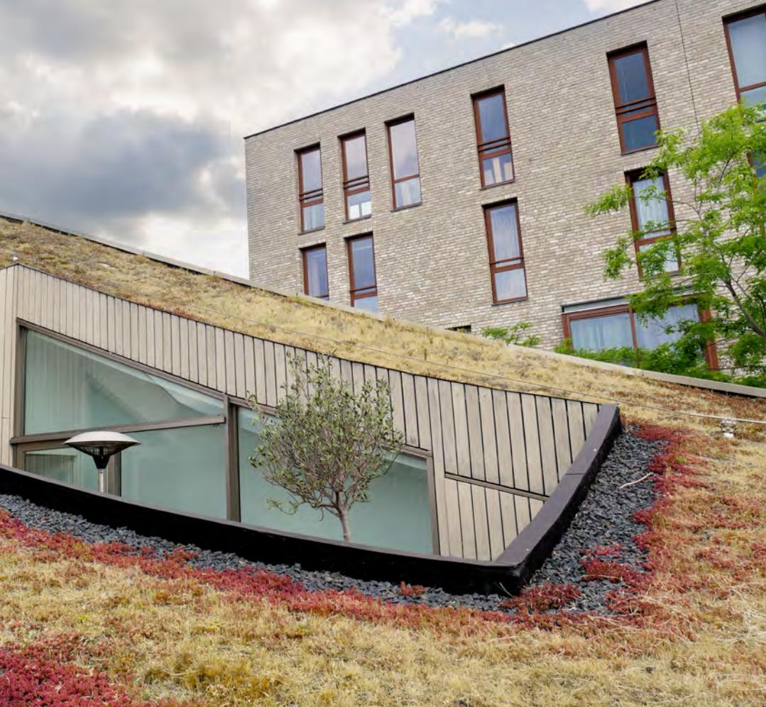
bei Dachneigungen bis zu 45 Grad sind möglich, sofern spezielle Schubsicherungen gegen Abrutschen angebracht werden. Wichtig ist, dass die Art der Begrünung beim Bau berücksichtigt und die Dachkonstruktion darauf abgestimmt wird. Nachträgliche Begrünungen sind möglich, sofern die statischen Eigenschaften des Daches nachgewiesen werden können.
