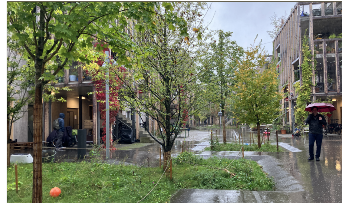
Abbildung 3: Entwässerung neu gedacht. Regenwasser fliesst oberirdisch in vertiefte Pflanzbeete Quelle: plan:team
